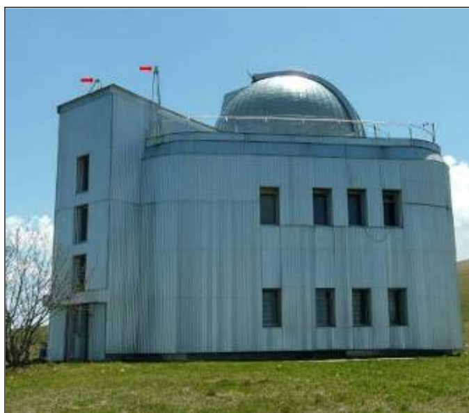
Рис. 16. Места установки оборудования контроля атмосферных условий вблизи крупнейшего российского телескопа БТА.
