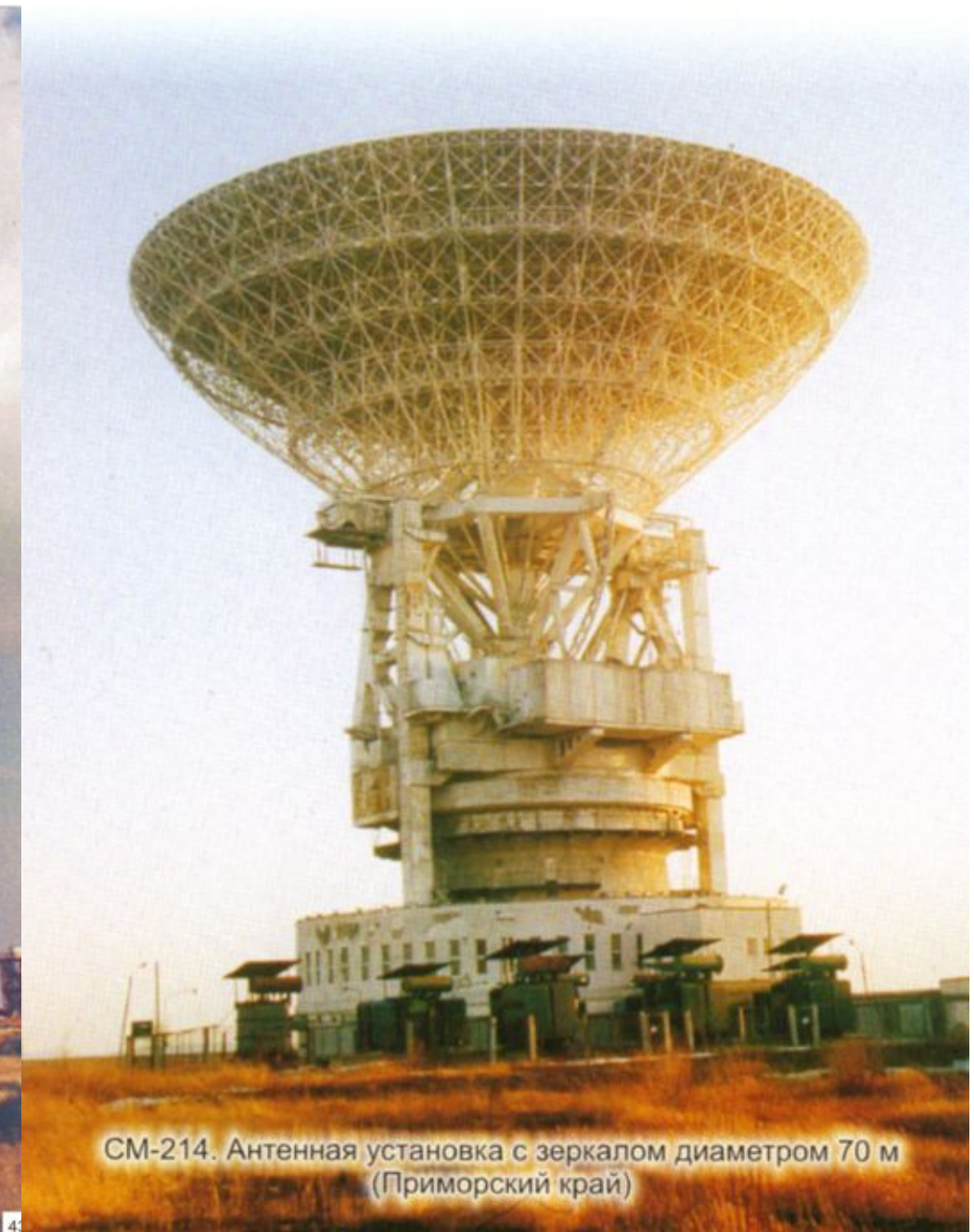
СМ-214. Антенная установка с зеркалом диаметром 70 м. Самая крупная антенная установка России и одна из крупнейших в мире.
